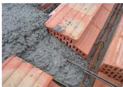
Detail stropu počas betónáže
